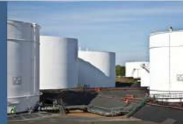
CONSTRUCCIÓN DE TANQUES DE ALMACENAMIENTO Y RECIPIENTES A PRESIÓN
