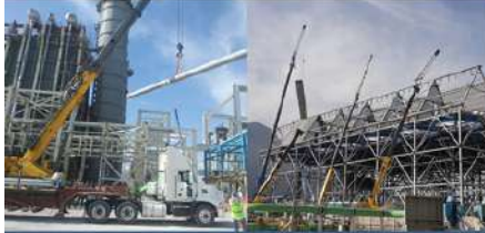
MONTAJE DE TUBERÍA Y AEROCONDENSADOR
