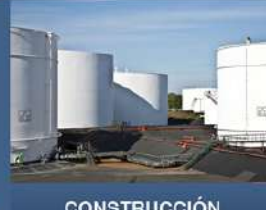
CONSTRUCCIÓN DE TANQUES DE ALMACENAMIENTO Y RECIPIENTES A PRESIÓN
