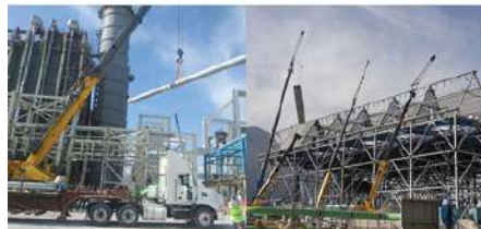
MONTAJE DE TUBERÍA Y AEROCONDENSADOR
