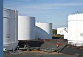
CONSTRUCCIÓN DE TANQUES DE ALMACENAMIENTO Y RECIPIENTES A PRESIÓN
