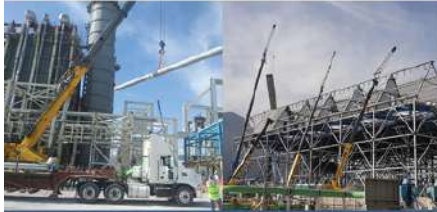
MONTAJE DE TUBERÍA Y AEROCONDENSADOR
