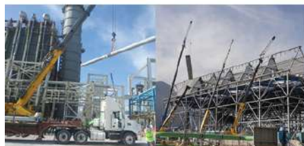
MONTAJE DE TUBERÍA Y AEROCONDENSADOR
